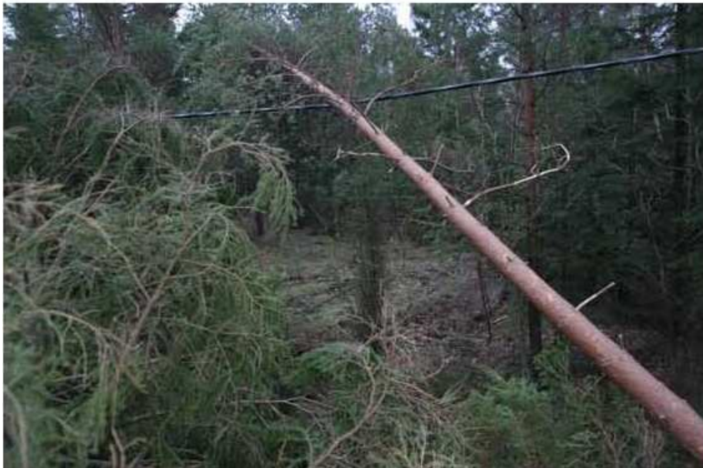
Слика 4.1.1.6 Оборено стабло после олује наслања се на СИП који је и даље под напоном
