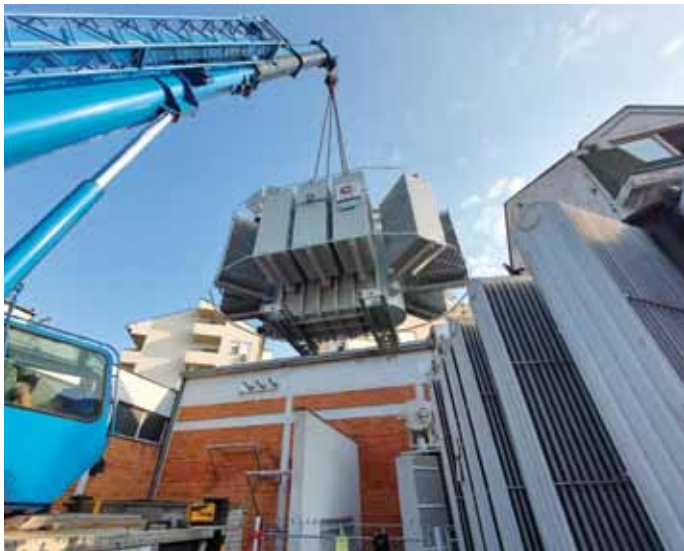
Инсталација новог трансформатора у ТС 35/10 kV Пожаревац 3 - Центар
