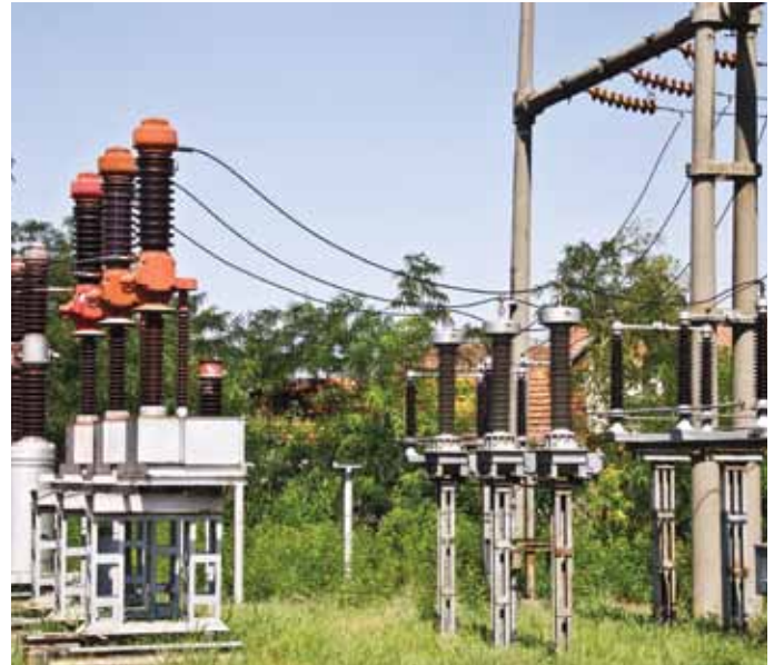
Значајна и приоритетна реконструкција ТС 110/35 kV/kV „Зрењанин 1“
