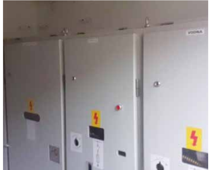
Изграђена нова ТС за бољи квалитет снабдевања житеља и посетилаца Куршумлијске бање
