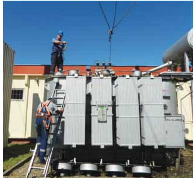
Реконструкцијом тџрафостаница до мирније зиме
