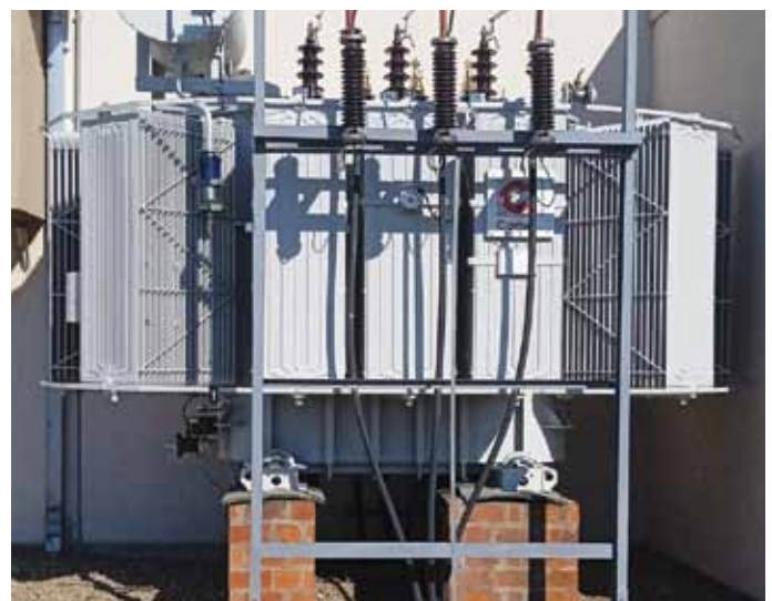
Инсталација новог трафоа у ТС 35/10 Млекара у Крагујевцу
