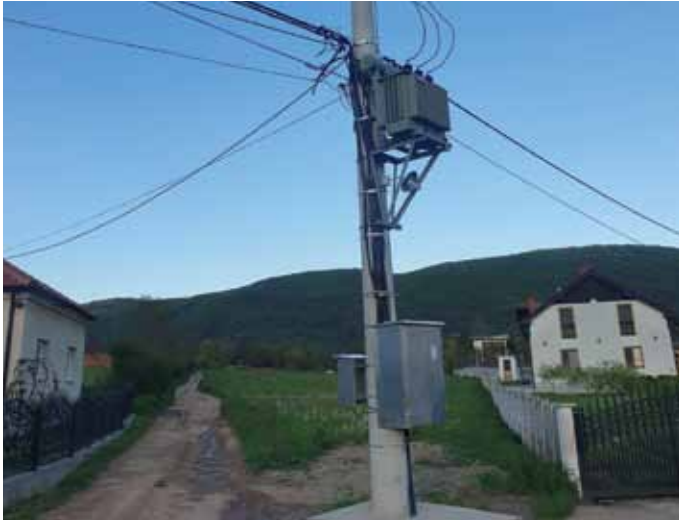
Нова стубна трафостаница побољшала снабдевање пошрошача у селу Сиге
